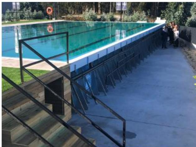
Les panneaux sont composés d'acier galvanisé ce qui signifie que la structure a subi un traitement spécial pour lutter contre la corrosion.
